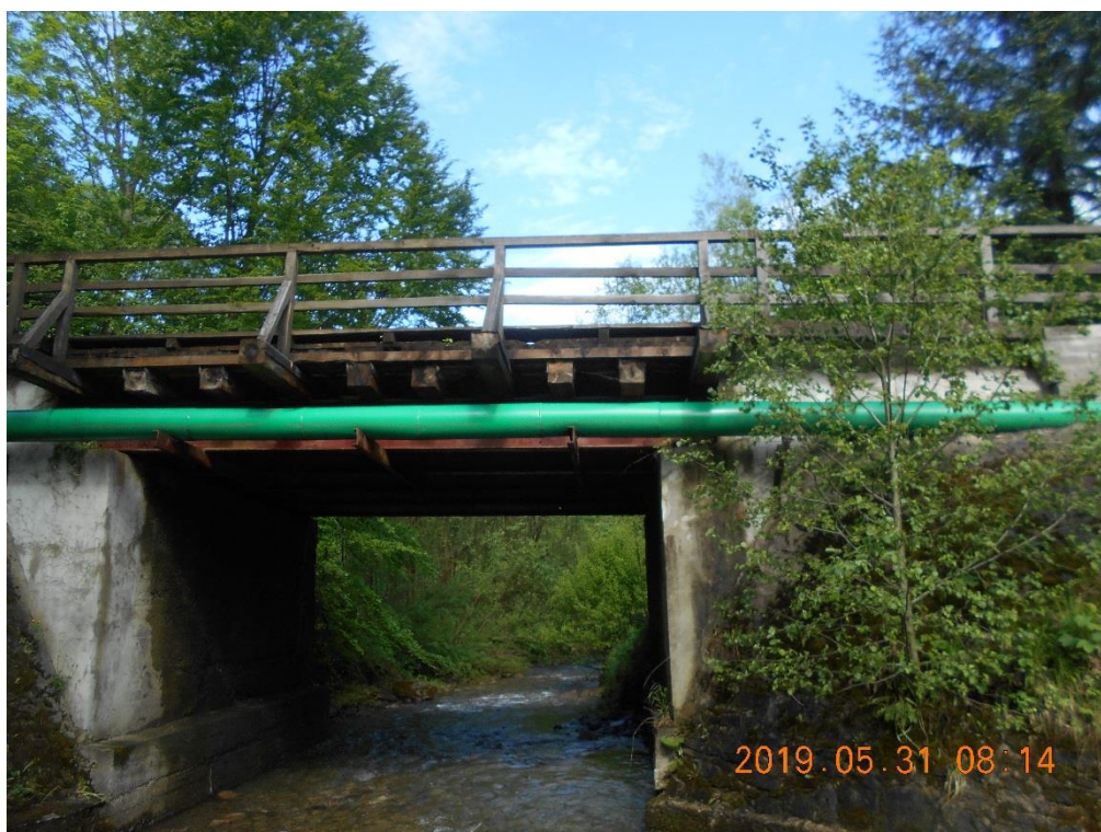
Zdj. 1 Widok od strony wody górnej.
