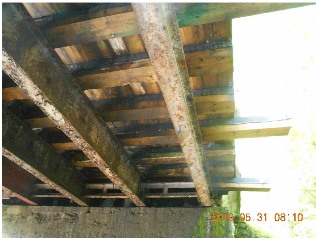
Zdj. 5 Stalowa konstrukcja mostu.
