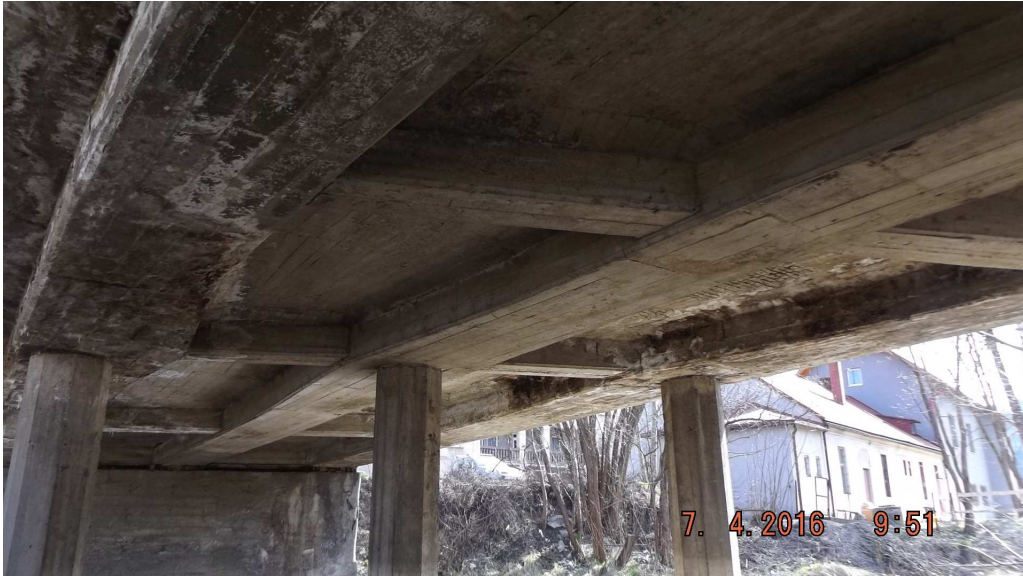
Rys. 2. Widok od spodu na konstrukcję pomostu
