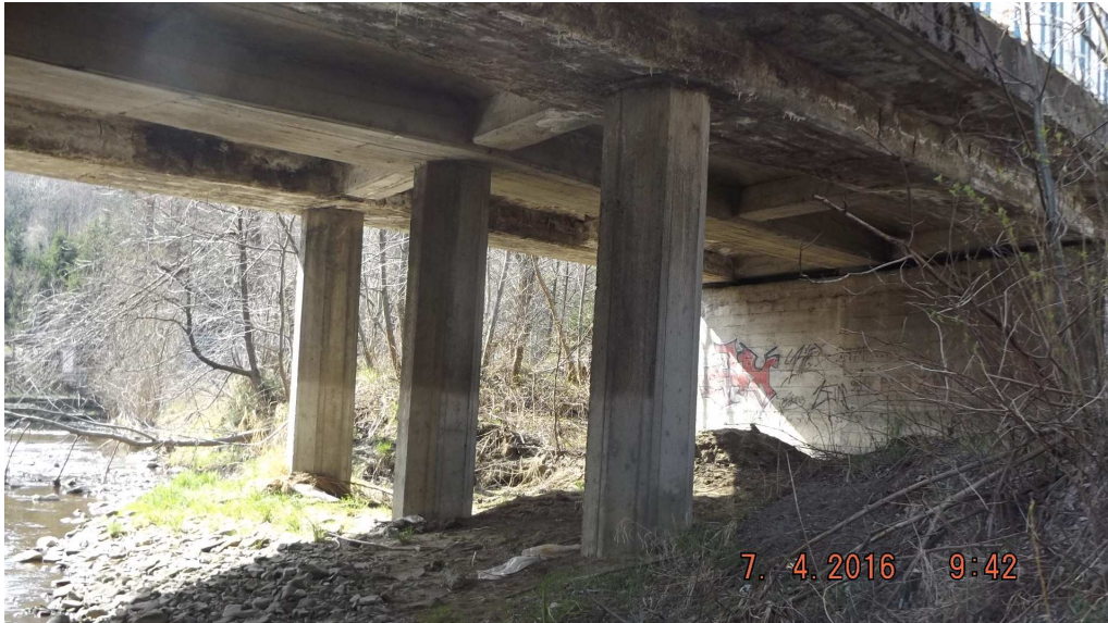
Rys. 4 Widok na filar
