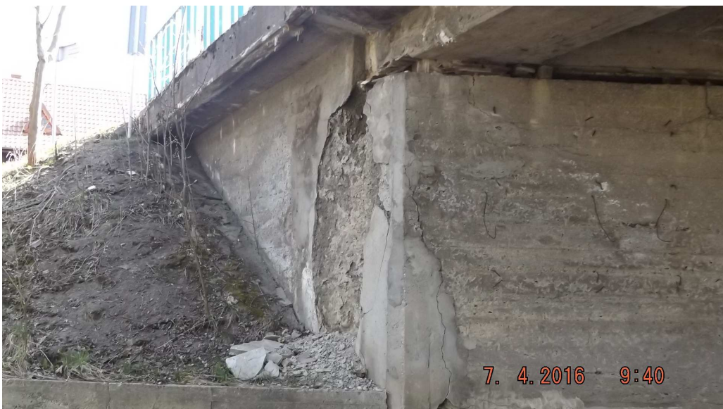
Rys. 3 Widok na przyczółek lewobrzeżny
