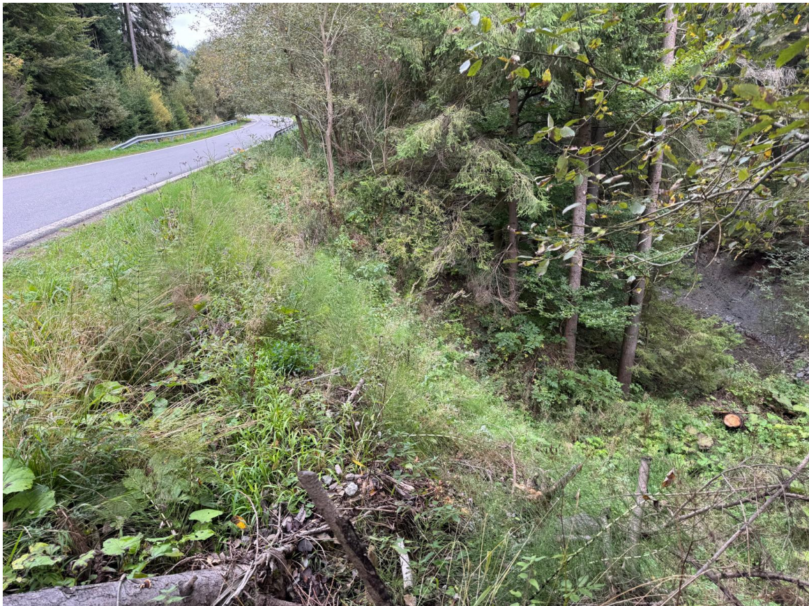
Fot.1 Widok w kierunku wschodnim na drogę powiatową oraz osuwisko w północnej części obszaru badań (fotografia własna).
