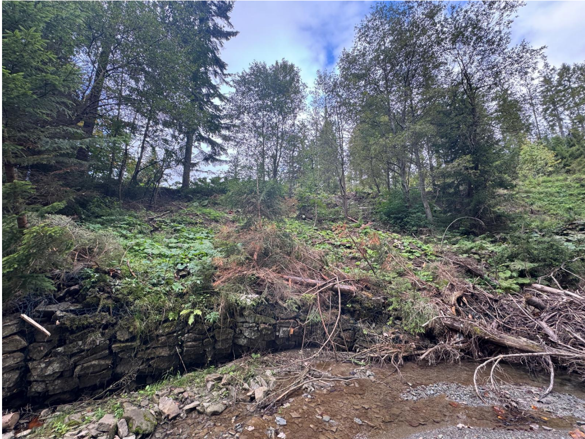
Fot. 2 Widok na skarpe osuwiskową (fotografia własna).
