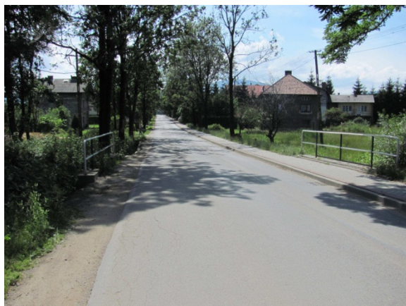
fot.1 widok obiektu w ciągu drogi
