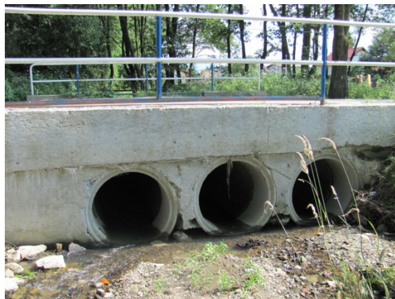
fot. 2. Widok obiektu z boku
