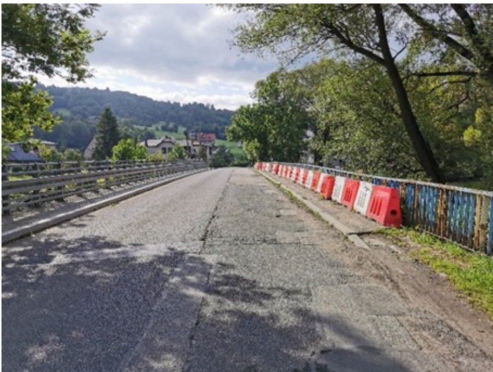
Ilustracja 3: Obiekt mostowy w ciągu DP 1481S dojazd do stacji PKP w km 0+081 w Rajczy - widok ogólny
