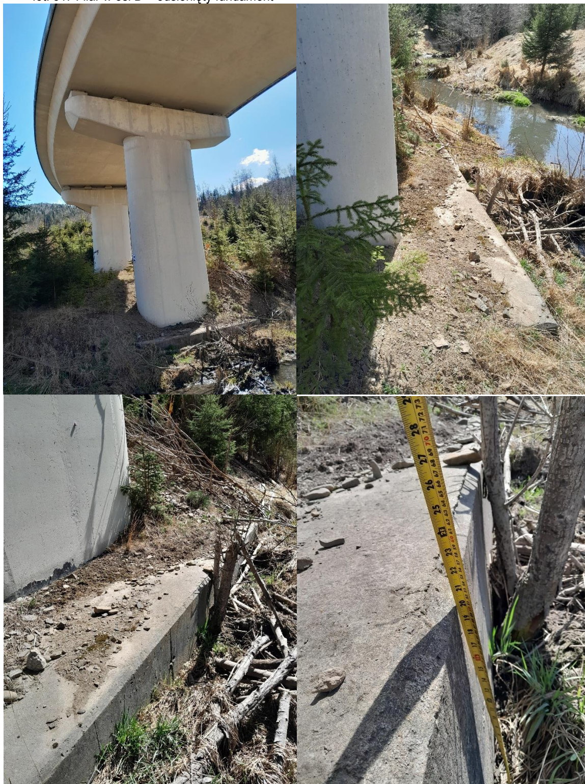
fot. 31. Filar w osi D – odsłonięty fundament
