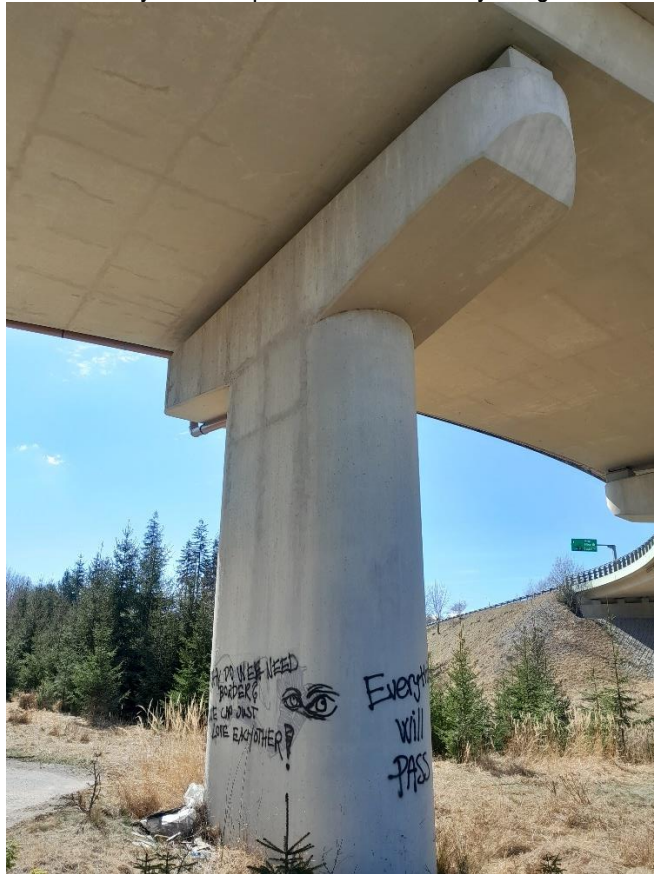
fot. 30. Filar w osi F – zanieczyszczenie powierzchni betonowych - graffiti
