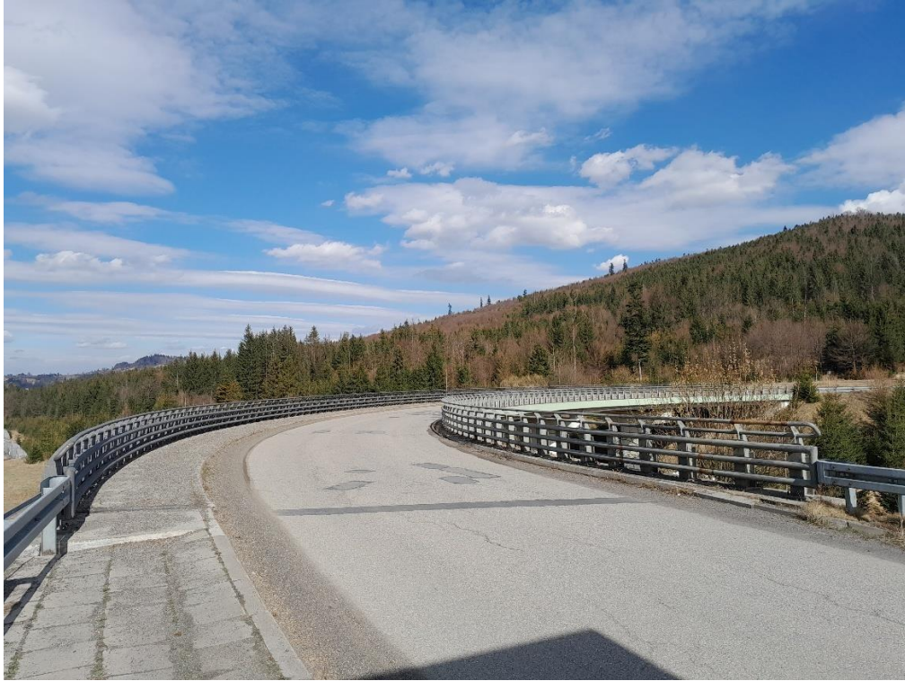
fot. 6. Widok dojazdu do obiektu od strony miejscowości Zwardoń. Widoczne spękania nawierzchni jezdni. Brak odcinka początkowego bariery po prawej stronie.
