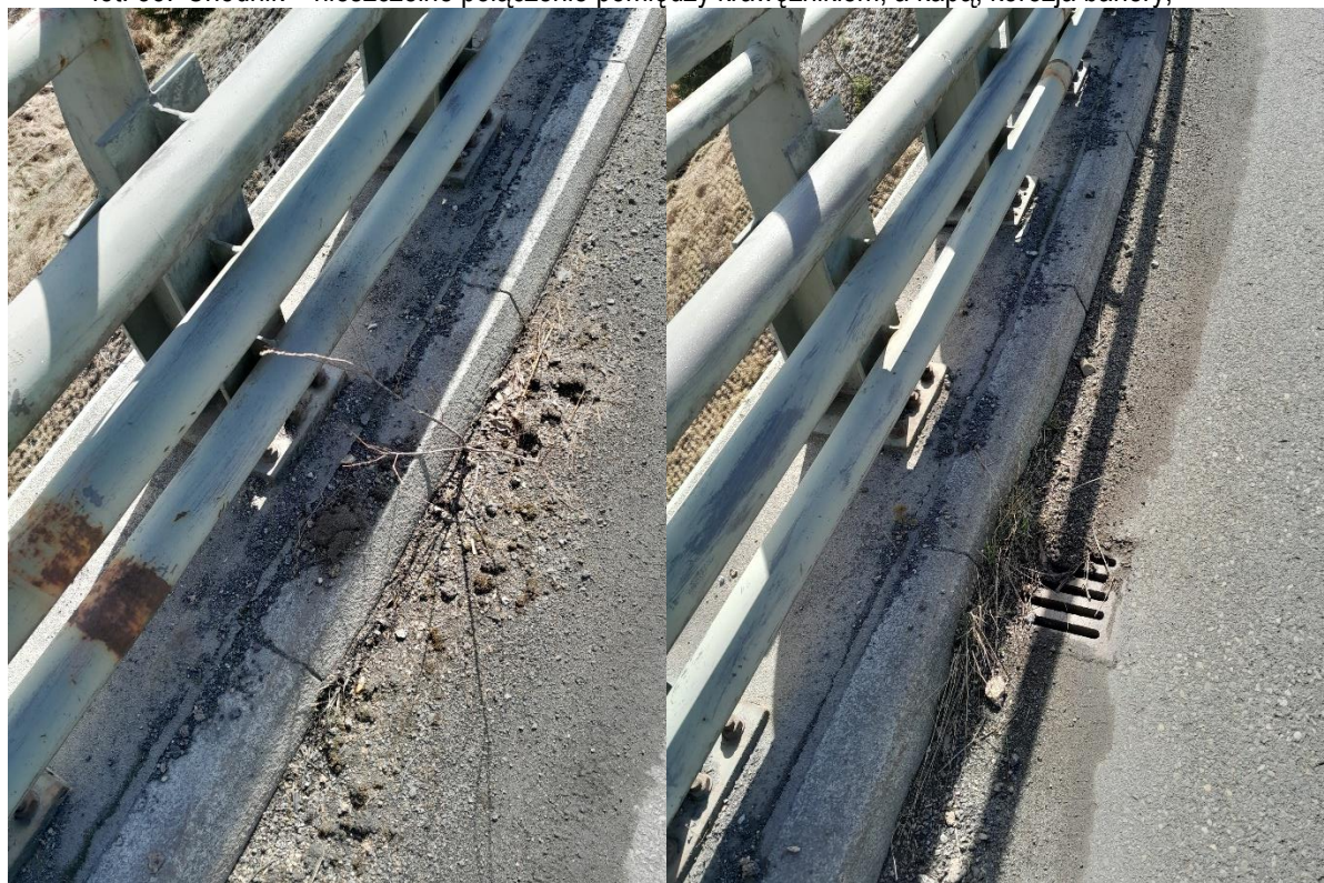
fot. 53. Chodnik – nieuszczelnne połączenie pomiędzy krawężnikiem, a kapą, korozja bariery,
