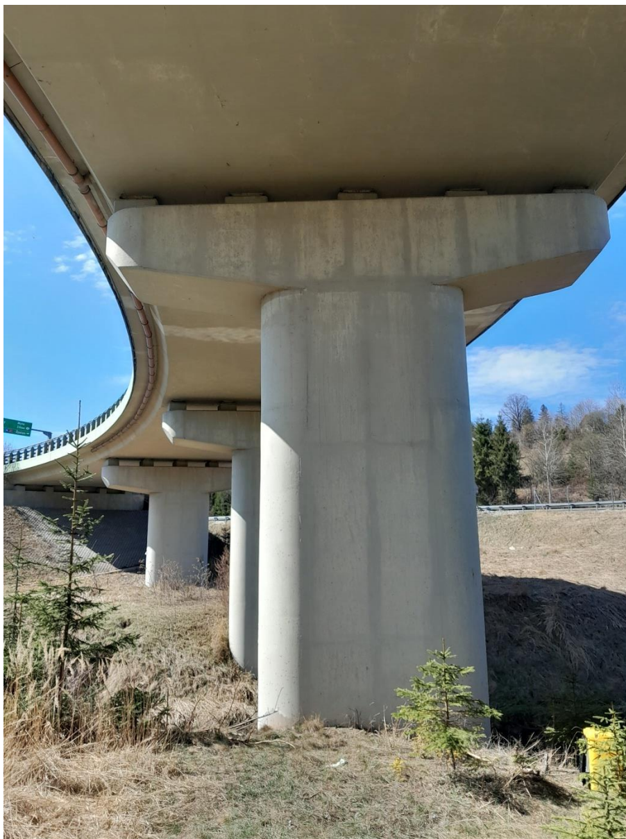
fot. 14. Widok filara w osi D od strony miejscowości Zwardoń
