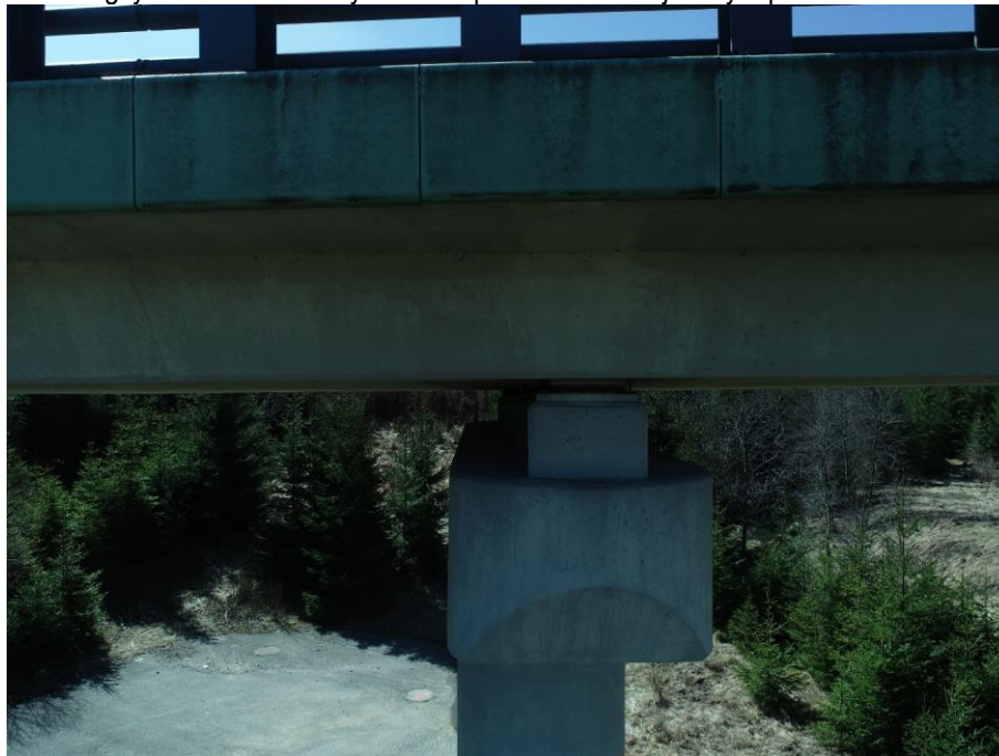
fot. 63. Deski gzymsowe – zacieki i wykwyty na powierzchni deski od strony wewnętrznej łuku drogi
