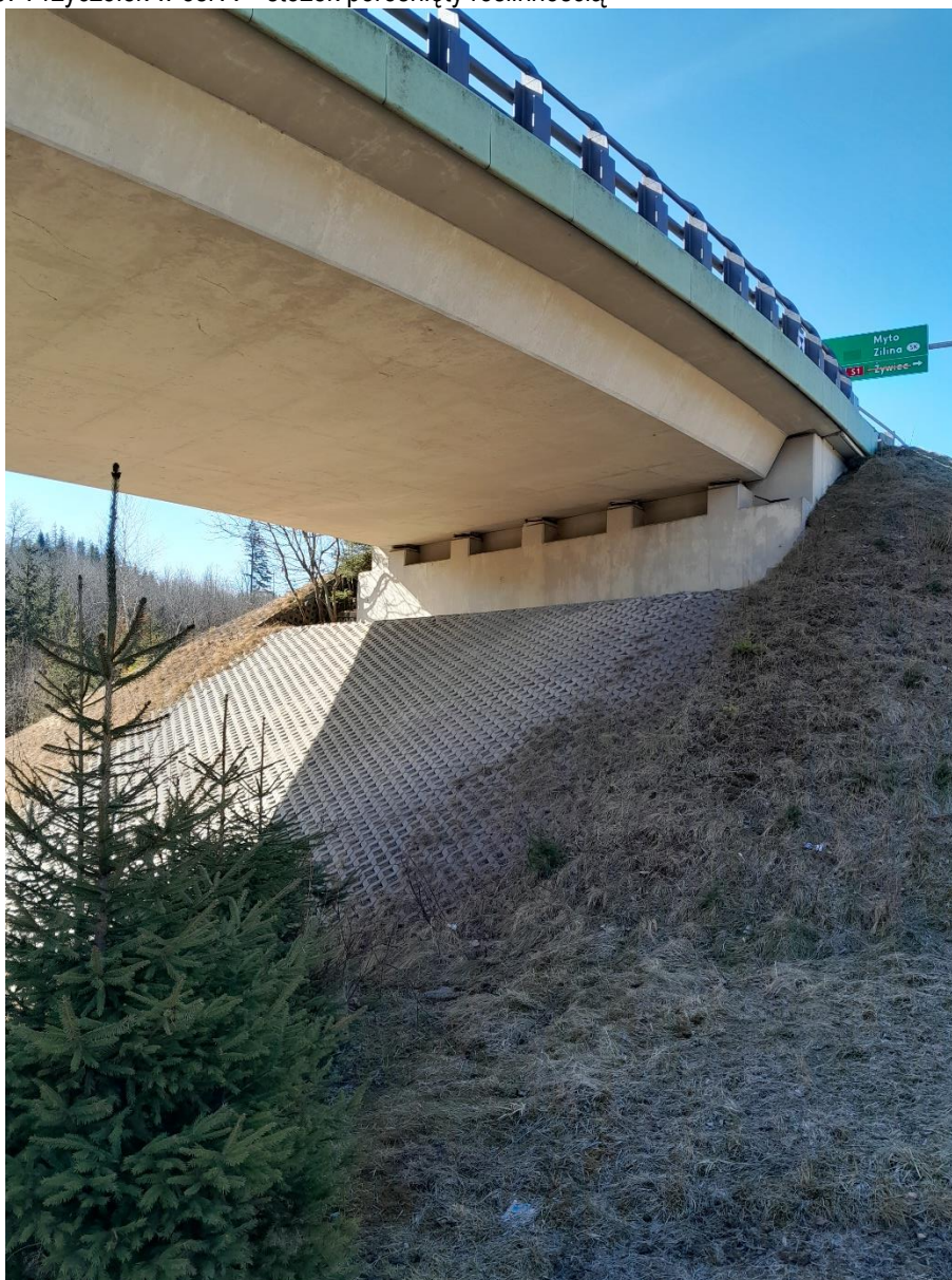
fot. 20. Przyczółek w osi A – stożek porośnięty roślinnością
