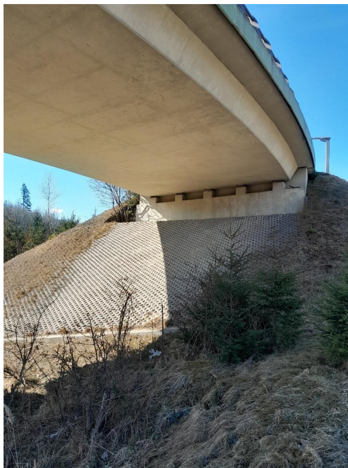
fot. 8. Widok przyczółka od strony miejscowości Zwardoń (oś G). Zanieczyszczenie przyczółka graffiti. Ubytki umocnienia stożka nasypowego.
