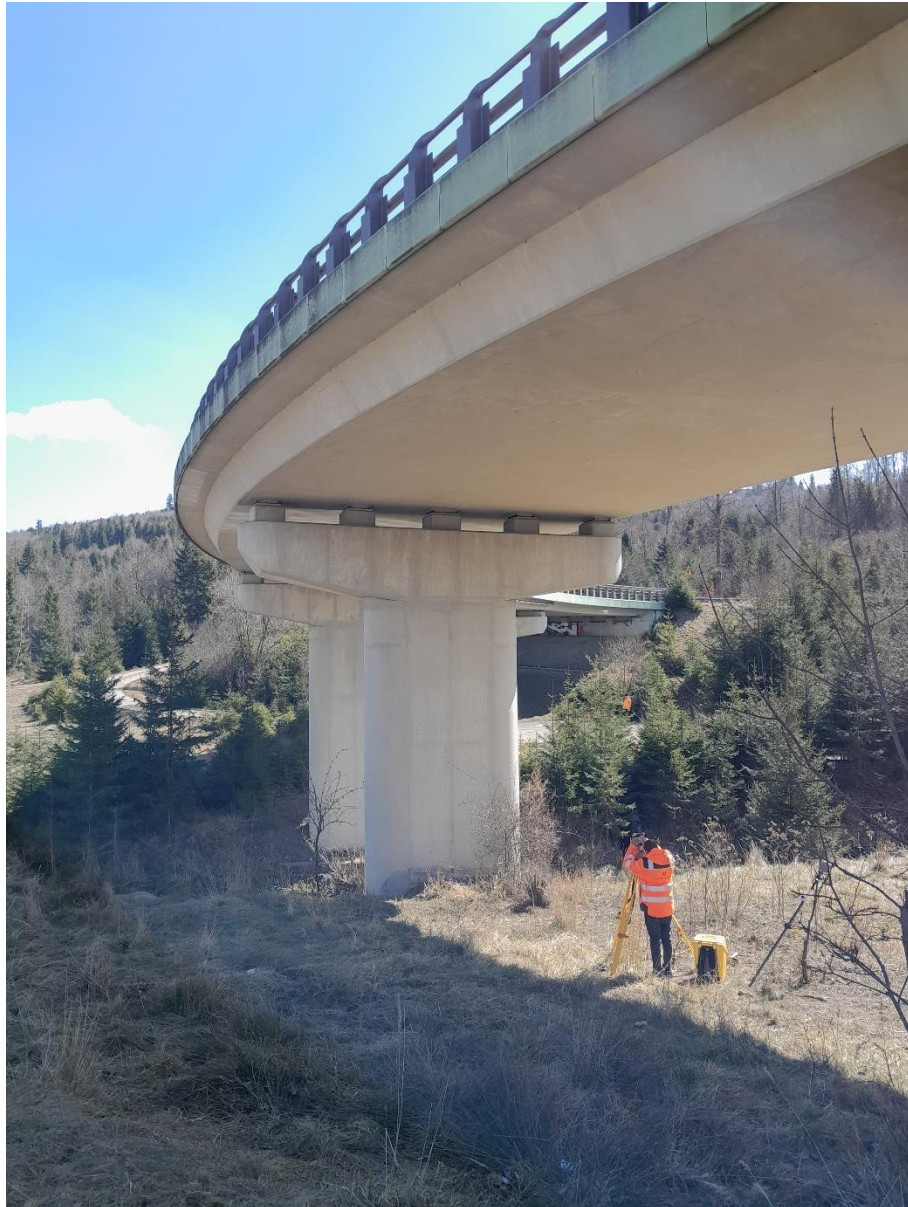
fot. 11. Widok filara w osi C od strony miejscowości Myto
