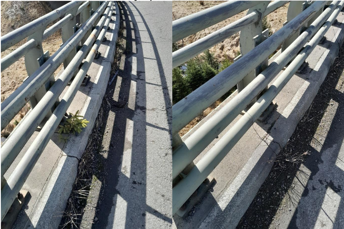
fot. 53. Chodnik – nieuszczelnne połączenie pomiędzy krawężnikiem, a kapą, korozja bariery,
