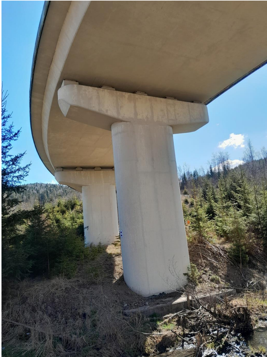
fot. 13. Widok filara w osi D od strony miejscowości Myto. Odsłonięcie ławy fundamentowej.
