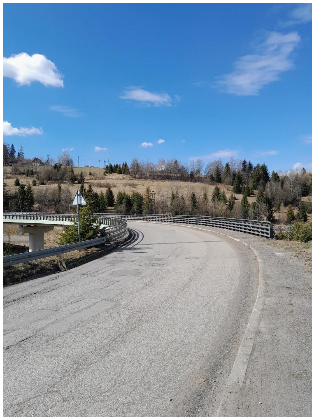
fot. 6. Widok dojazdu do obiektu od strony miejscowości Zwardoń. Widoczne spękania nawierzchni jezdni. Brak odcinka początkowego bariery po prawej stronie.
