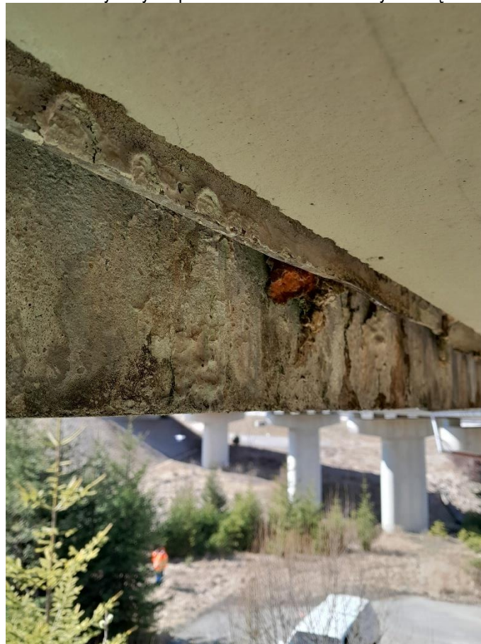
fot. 63. Deski gzymsowe – zacieki i wykwyty na powierzchni deski od strony wewnętrznej łuku drogi
