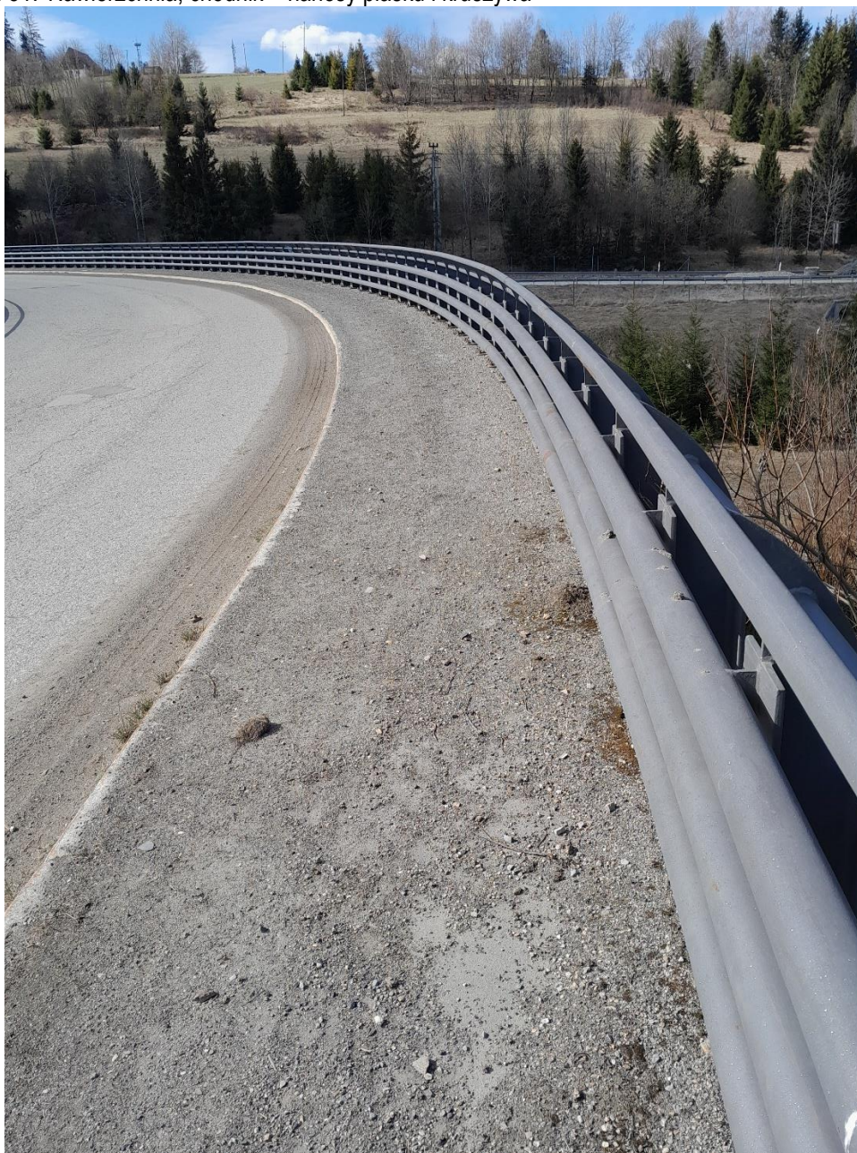
fot. 51. Nawierzchnia, chodnik – nanosy piasku i kruszywa
