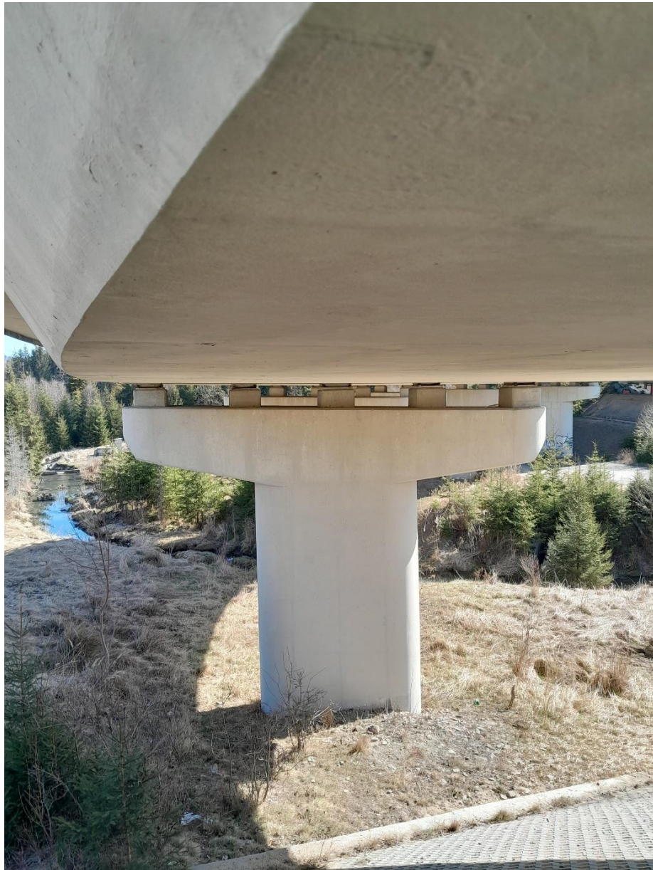
fot. 9. Widok filara w osi B od strony miejscowości Myto
