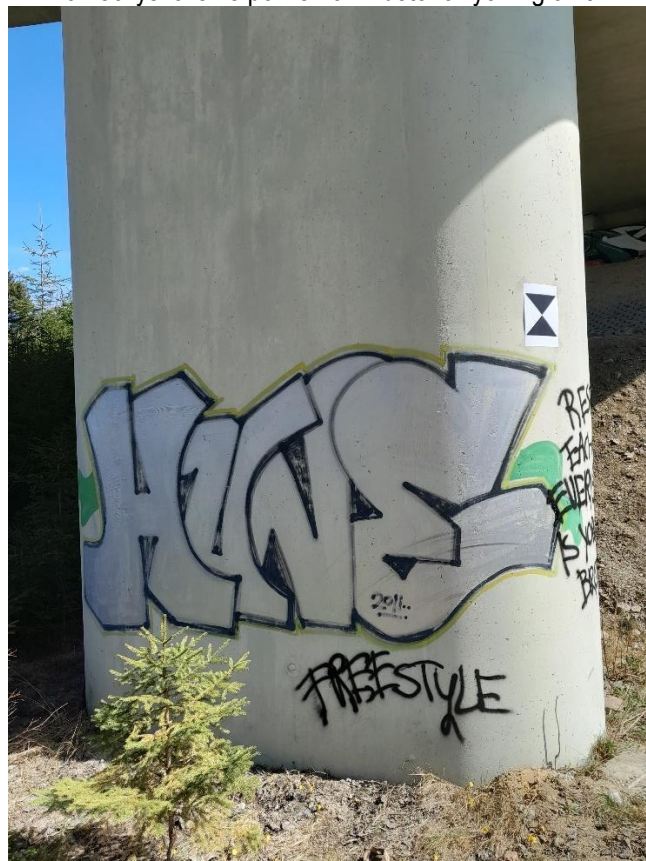
fot. 30. Filar w osi F – zanieczyszczenie powierzchni betonowych - graffiti
