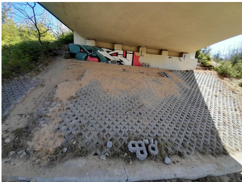
fot. 8. Widok przyczółka od strony miejscowości Zwardoń (oś G). Zanieczyszczenie przyczółka graffiti. Ubytki umocnienia stożka nasypowego.
