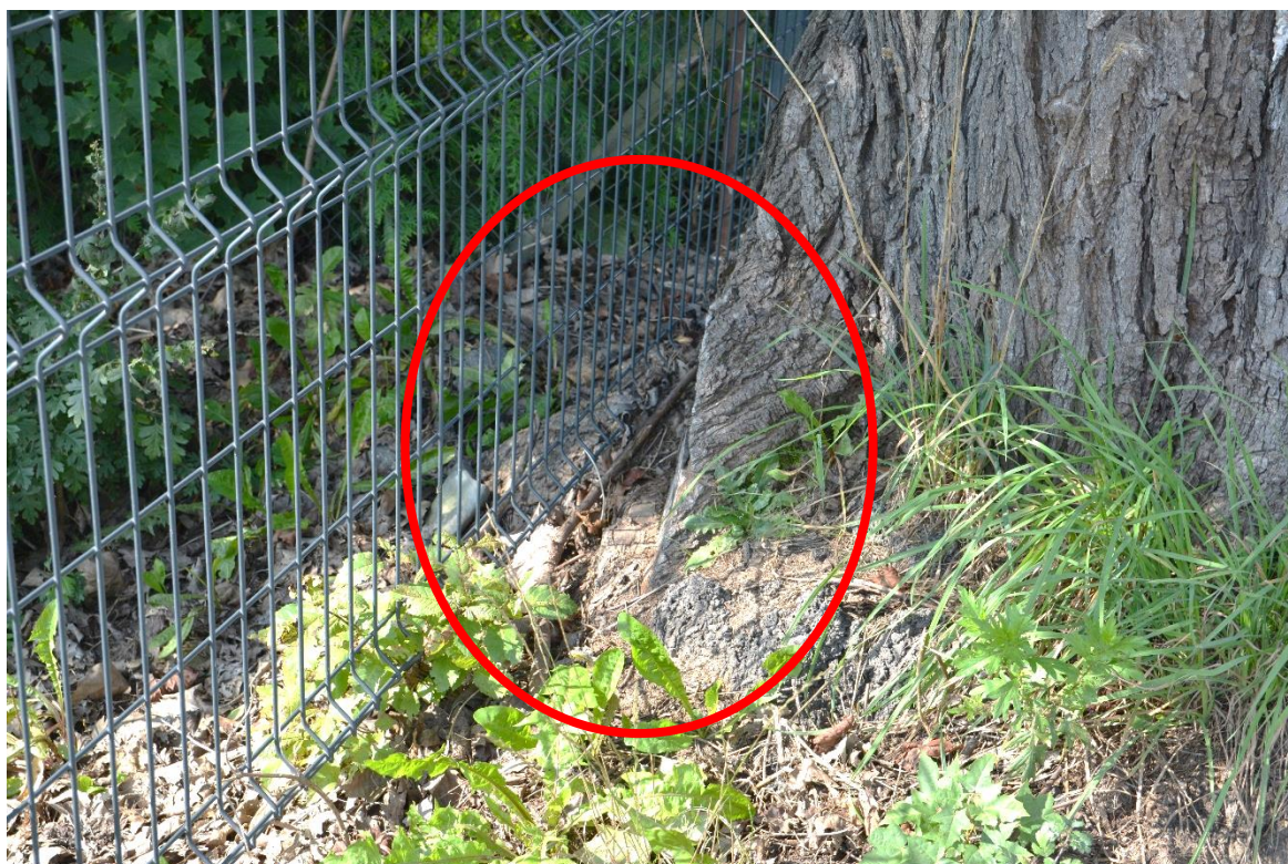
Uszkodzenie szyi korzeniowej od strony ogrodzenia
